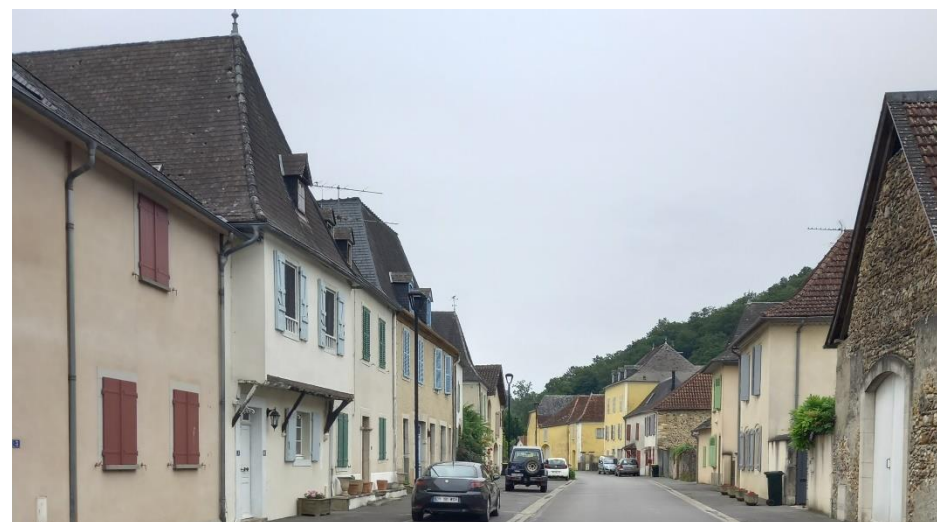
Une partie du tissu bâti ancien sur l'un des deux axes structurants du bourg
