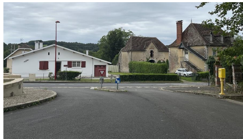
Laà-Mondrans : Maison landaise à gauche avec un toit très étendu et assez bas
