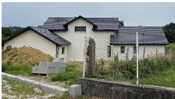
Lahourcade : forme d'implantation en incohérence avec le contexte bâti
