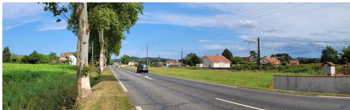
Axe routier principal (D817) et voie de chemin de fer traversant Ramous
