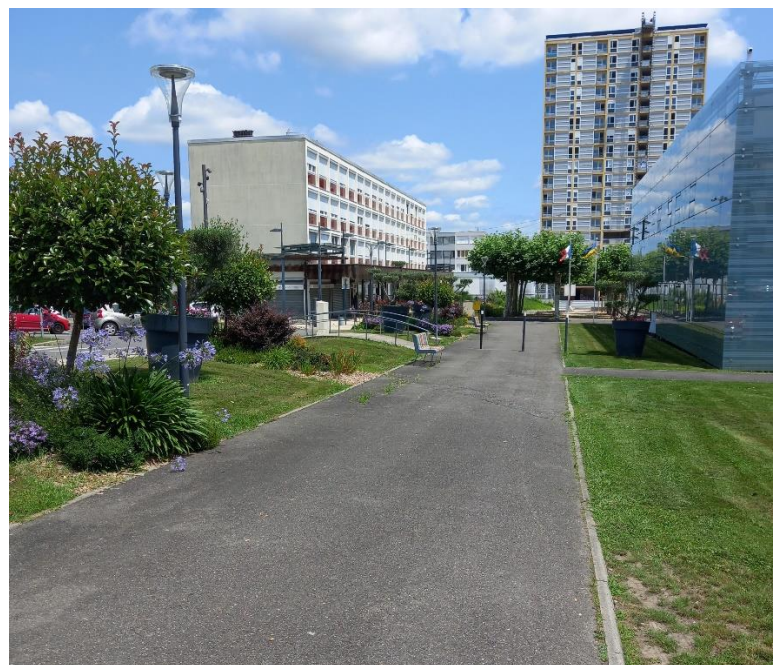
3 : Etat actuel des bâtiments témoins de l'expansion industrielle, Ville de Mourenx
