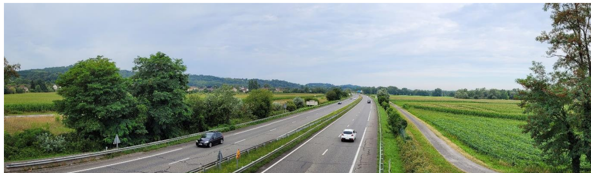
Vue du pont au-dessus de l'autoroute A64 en direction de l'ouest, au niveau de Biron
