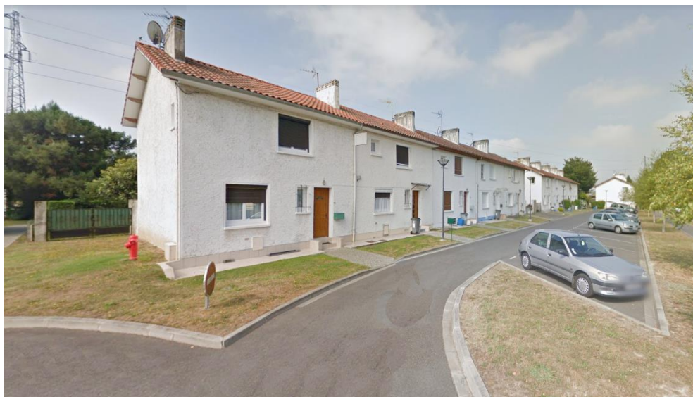
4 : Artix, Cités ouvrières, zones protégées par le PLU. (Source : Google Street View)
