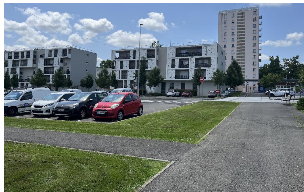
5 : Redynamisation des bâtis anciens, Ville de Mourenx
