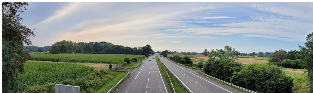
Vue du pont au-dessus de l'autoroute A64 en direction de l'est, au niveau de Biron
