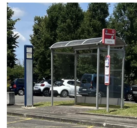
Abri bus commune de Noguères – arrêt 114 Tennis
