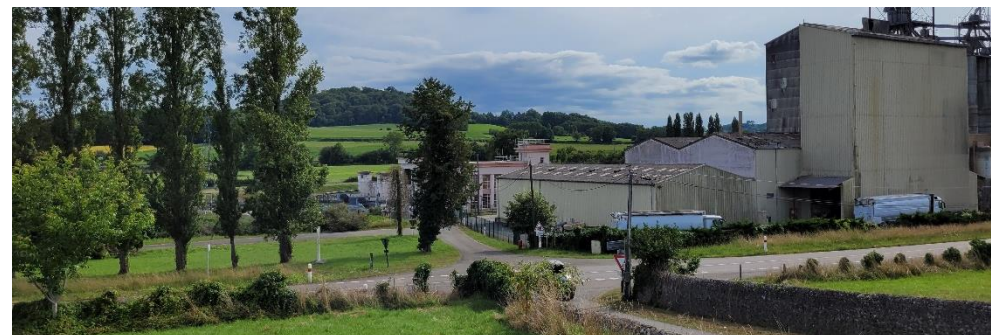
Barrage hydroélectrique le long du gave de Pau à Baigts-de-Béarn
