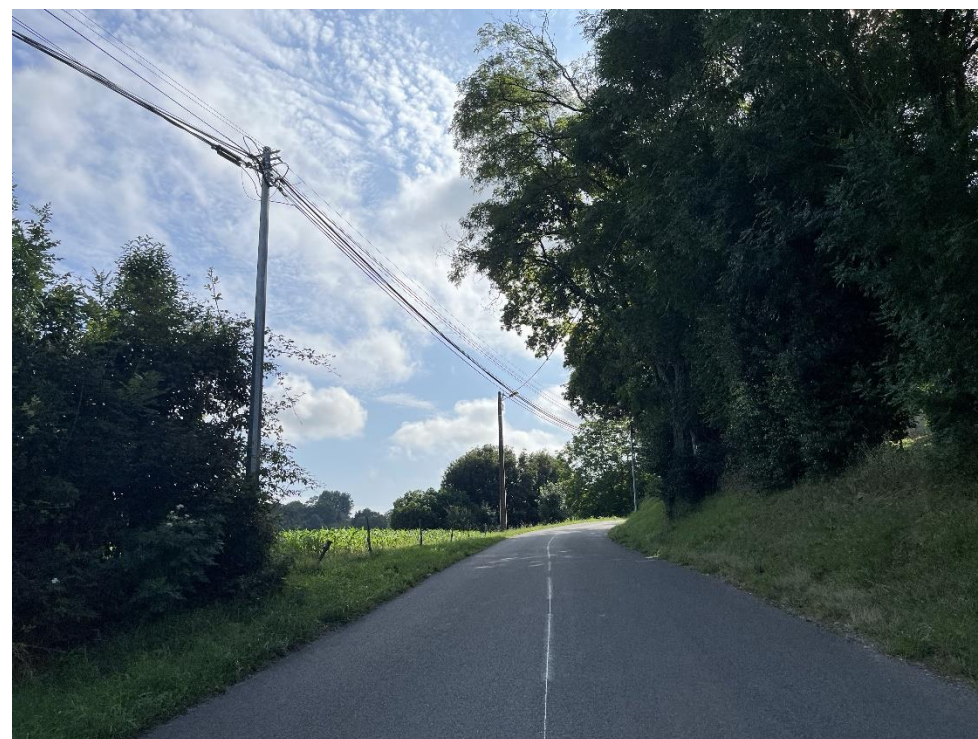
Route du Château (D663) sur la commune de Serres-Sainte-Marie
