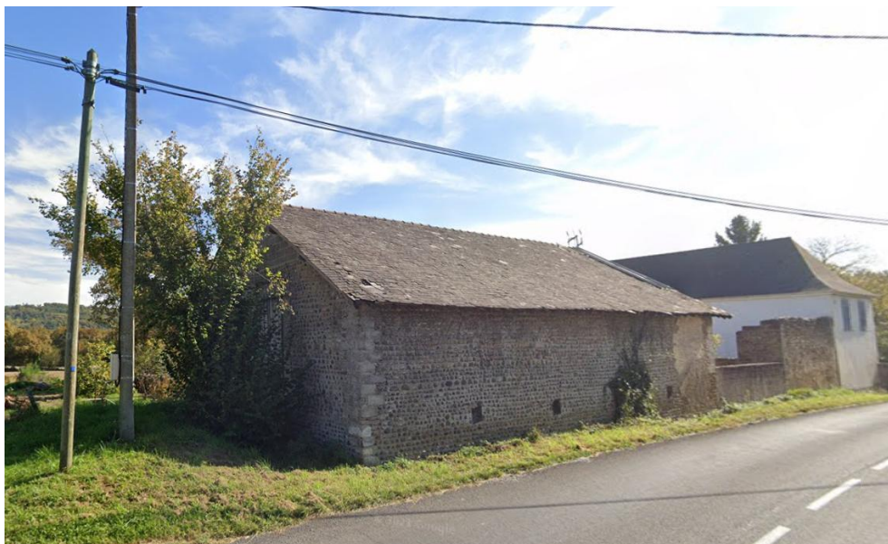
Exemple d'un bâtiment pouvant faire l'objet d'un changement de destination, Route de Mourenx, Monein
